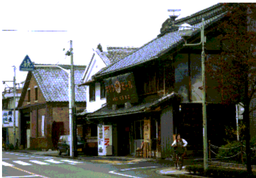
出典：桐生新町伝統的建造物群保存地区／桐生市HPより
