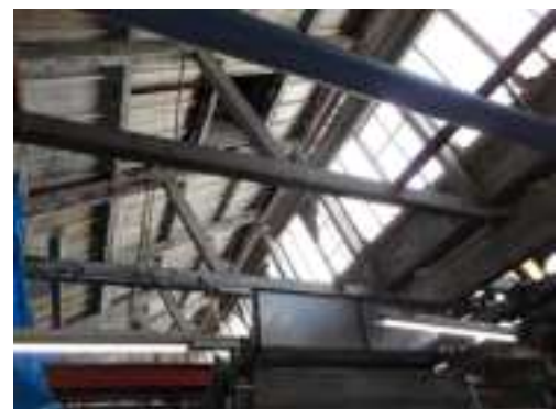
ノコギリ屋根工場内部
