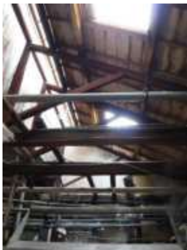
小池染色 （ノコギリ屋根工場内部）
