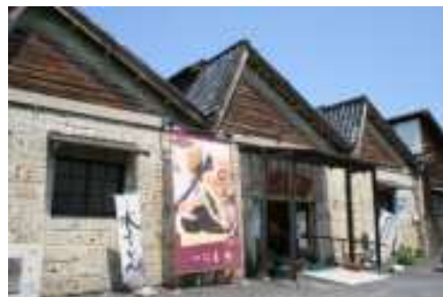
ノコギリ屋根工場
