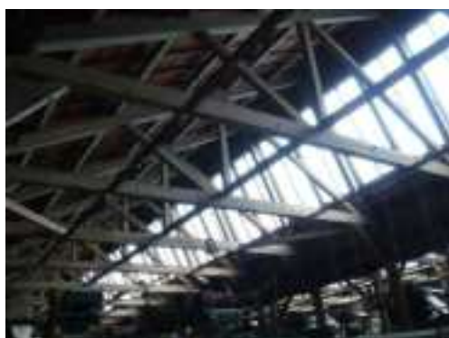
北側に採光窓のある工場内部
