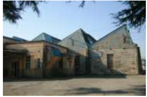
ノコギリ屋根工場
