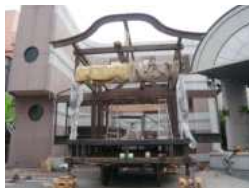
組み立て中の屋台
