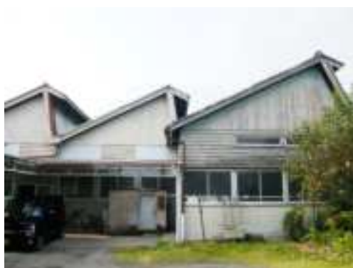
ノコギリ屋根工場
