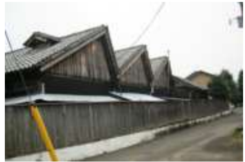
ノコギリ屋根工場
