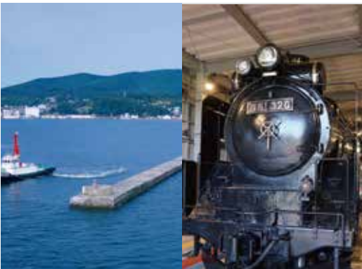
小樽港北防波堤(小樽市)
