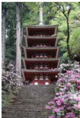
室生寺の五重塔
