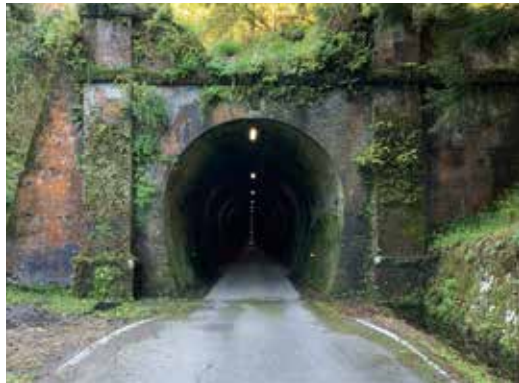
山中トンネル
