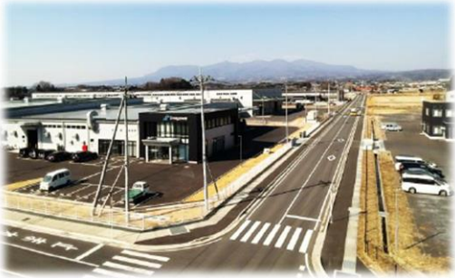
桐生武井西工業団地
