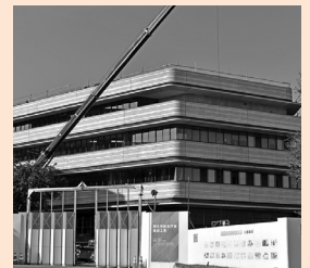
建設中の桐生市新本庁舎(R6.10.11現在)
