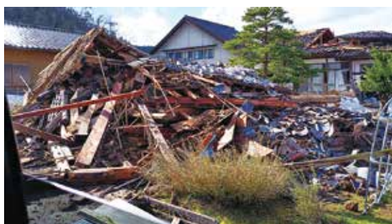
▲令和6年能登半島地震により倒壊した民家
